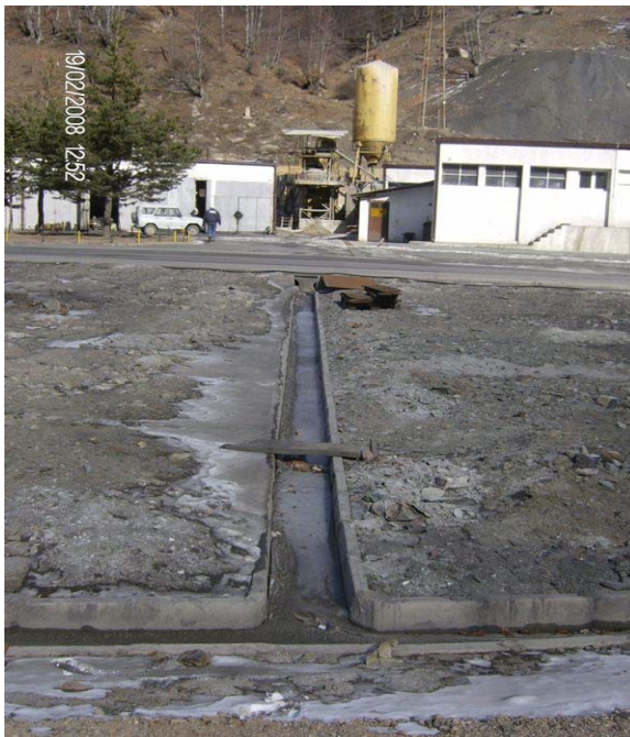
Сл.4 Таложник кај бетонска база и приклучок на атмосферски канал
