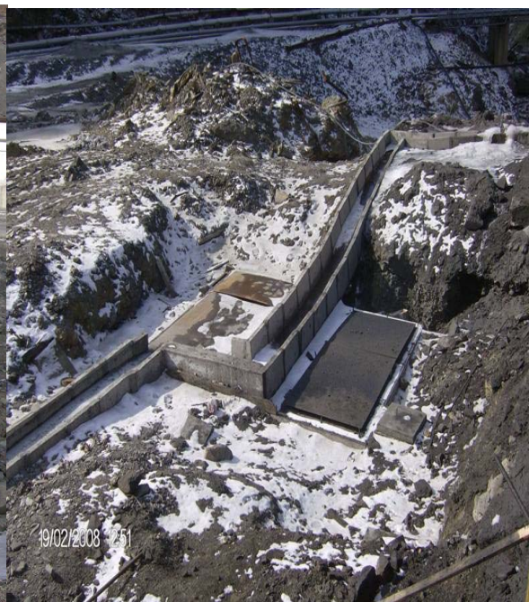
Сл.5 Таложник за сепарација на вода и масло, атмосферски канал и краен таложник пред испуст во реципиент
